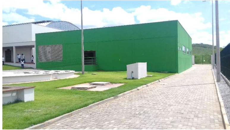
Figura 1 - Imagem frontal do bloco onde são instalados os laboratórios de Engenharia Civil.
