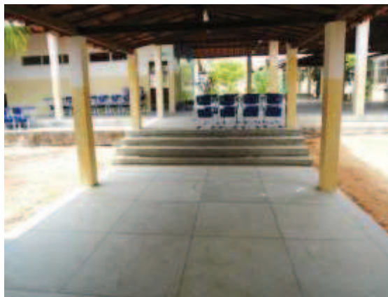
Escada de acesso à Área de Convivência
