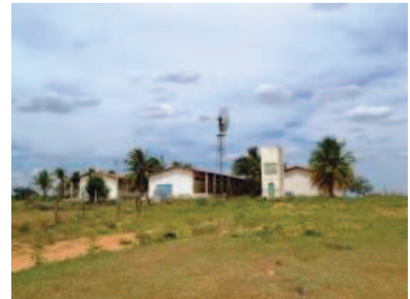
Vista de blocos II, IV e V desde o Galinheiro
