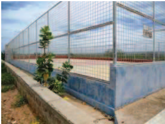
Quadra Poliesportiva descoberta
