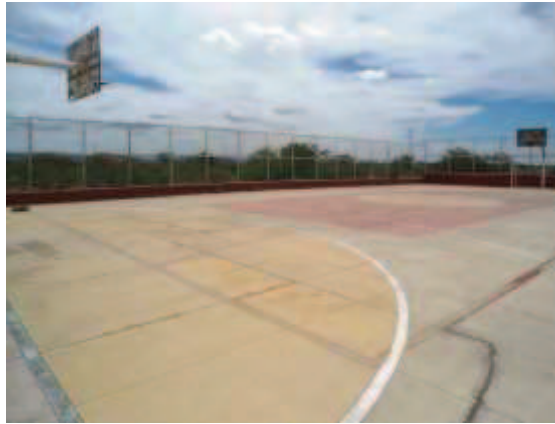
Quadra Poliesportiva descoberta
