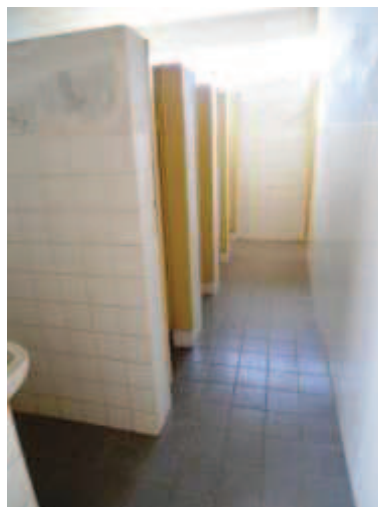
Sanitário feminino (estado de conservação semelhante aos demais)
