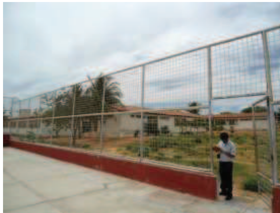
Quadra Poliesportiva descoberta
