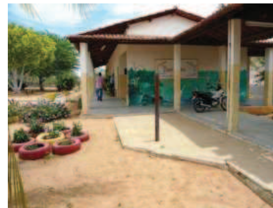
Vista para o corredor do segundo bloco
